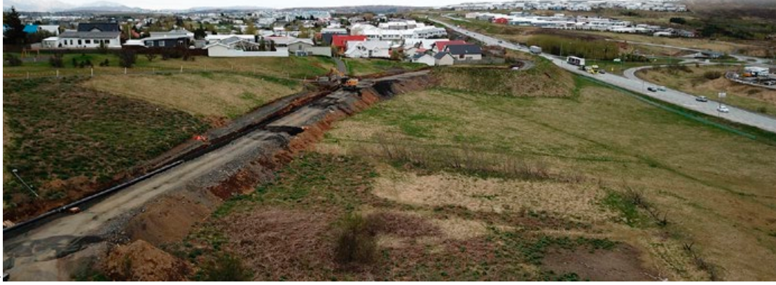
Samhliða tvöföldun Reykjanesbrautar er verið að gera nýjan göngu- og hjólastíg við Þorlákstún.
