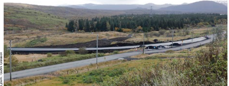
Tengingin frá hringtorginu við Flóttamannaveg að Kaldárseli er tilbúin.
