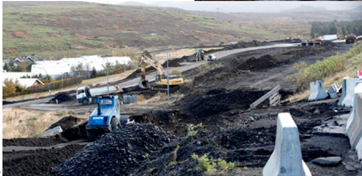
Enn er unnið í gathagerð norðan Klettahlíðar og að Sörlatorgi.
