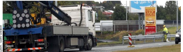
Aukið öryggi með nýju vegriði við undirgöngin undir Fjarðarhraun.
