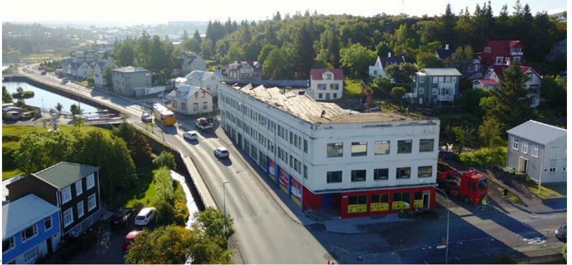
Svona leit Suðurgatan út um það leyti sem hafist var handa við að rífa húsið.
