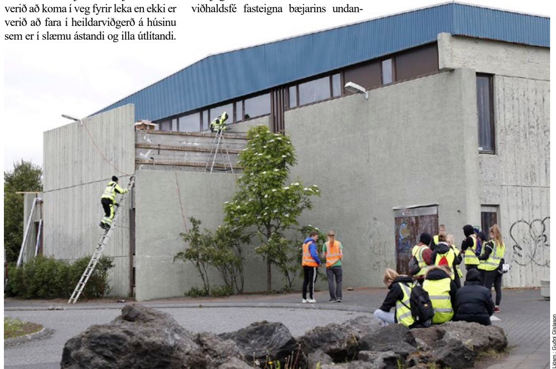
Verktakar unnu við að rífa klæðningu af útbyggingu sem hýsir leiksvið.
